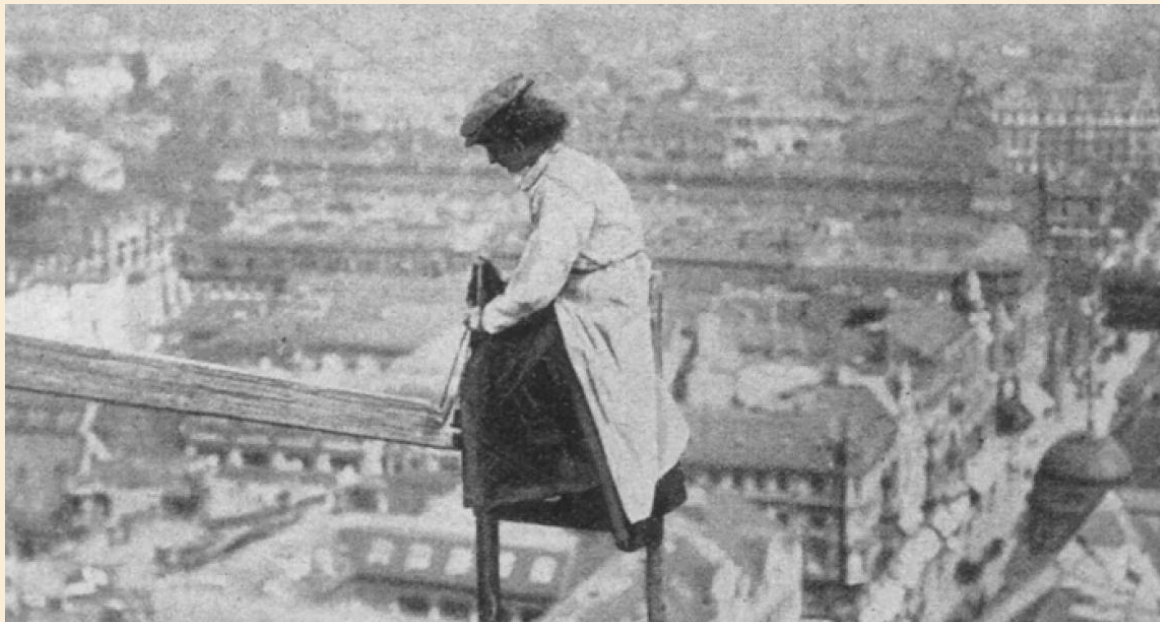
Figura 7. Uma mulher construtora em Berlim, realizando reparos no teto da Câmara Municipal de Berlim. 1910
